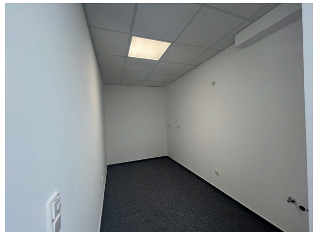
Küche (vor Umbau)
