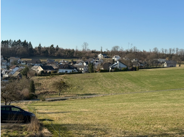
Blick auf das Neubaugebiet
