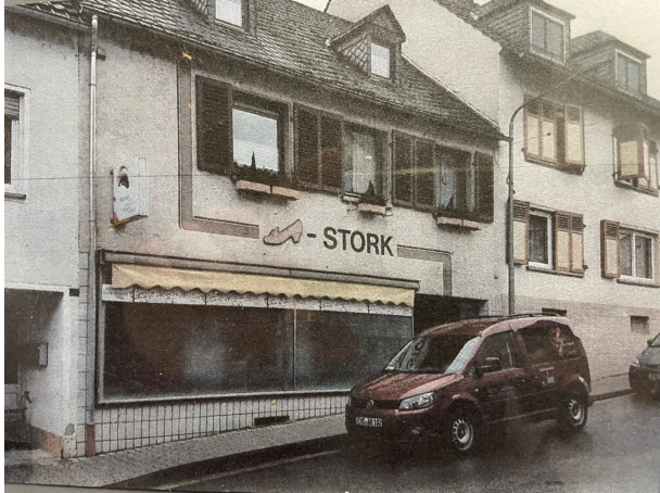
Außenansicht vor Umbau
